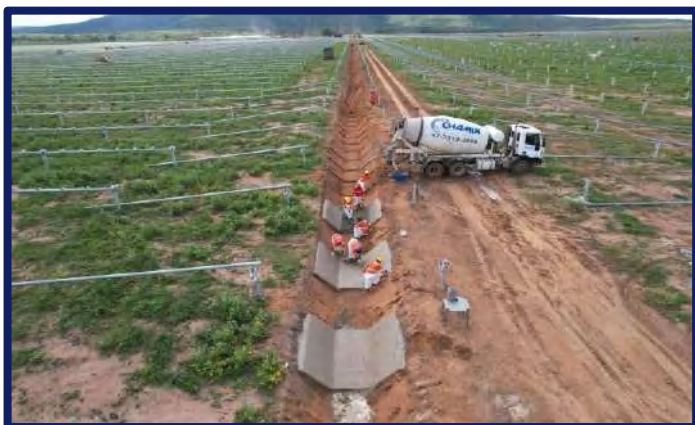
Montagem das primeiras linhas de painéis solares
