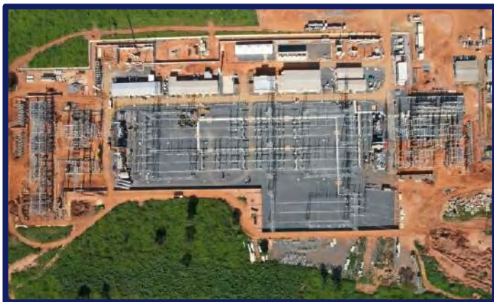
SE Solar Arinos – Vista aérea
