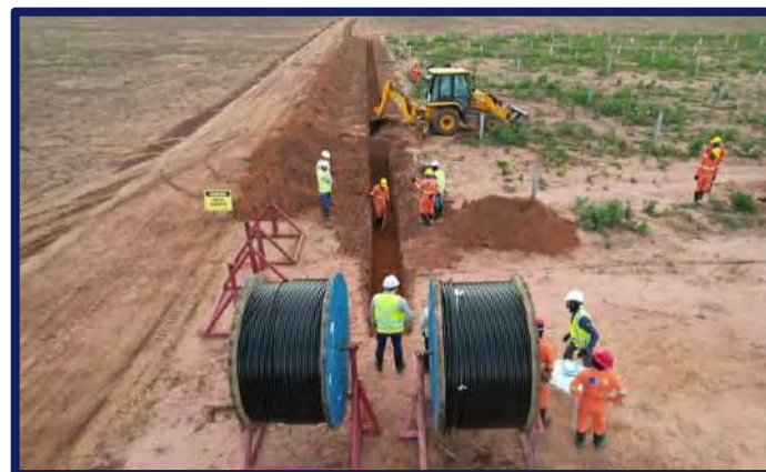
Instalação das linhas de conexão
